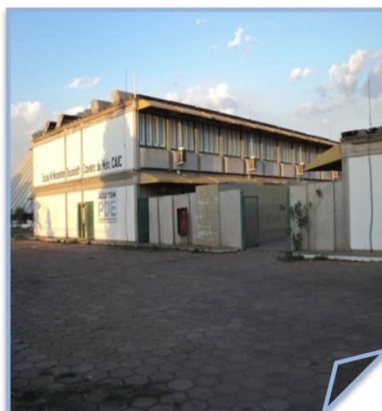
Foto 8: Acesso aos blocos de sala de aula Fonte: Acervo da pesquisadora
