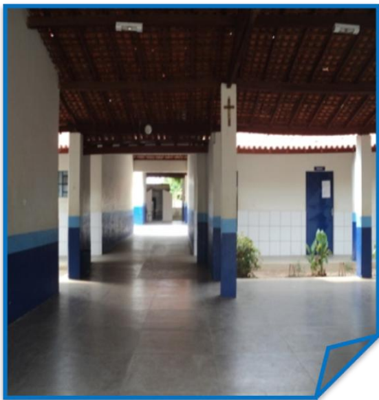
Foto 3: Pátio e bloco de salas de aula Fonte: Acervo da pesquisadora
