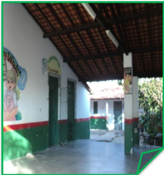
Foto 5: Pátio e bloco de salas de aula Fonte: Acervo da pesquisadora
